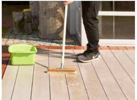
4. schrob in de richting van de vloerdelen
