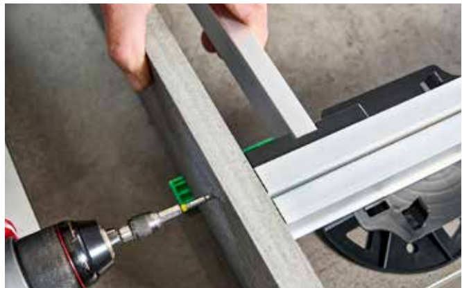
Fissaggio dei pannelli con adattatore per rinforzo trasversale
