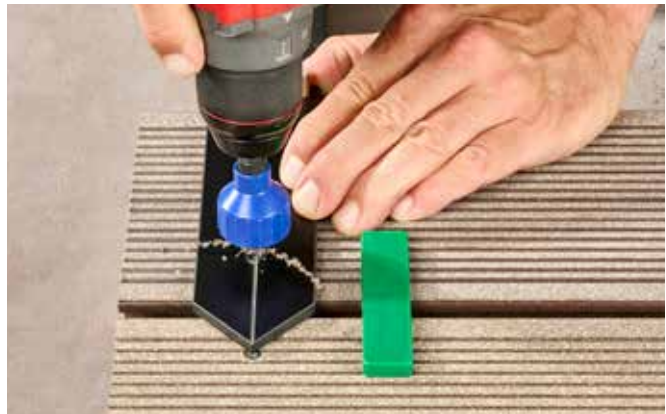
1. Appoggiare la dima in posizione centrale rispetto alla sottostruttura e segnare i fori
