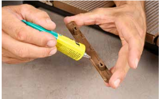
1. Kleber auf obere Kantenseite anbringen
