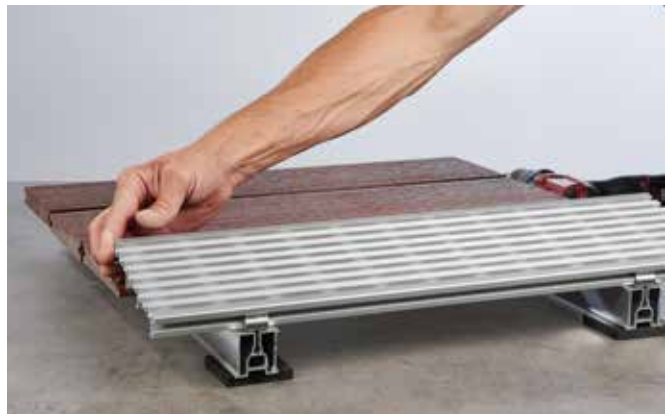
Terrassenbodenrost einklicken, Bild 2
